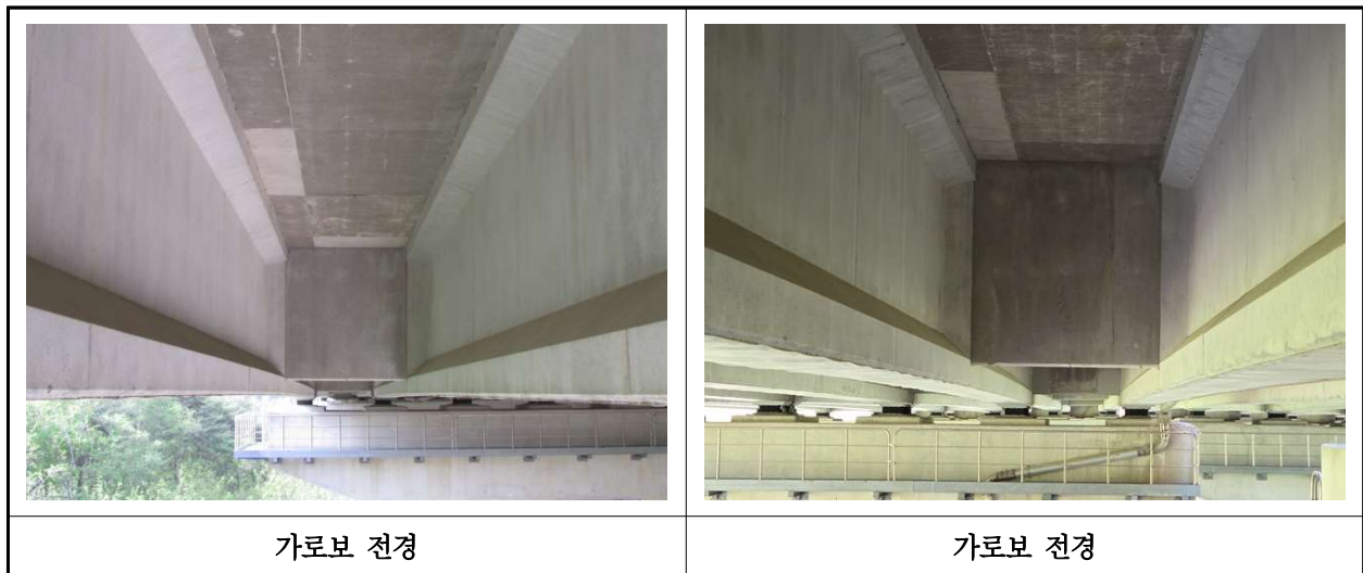
【사진 46.3.10】 가로보 전경
