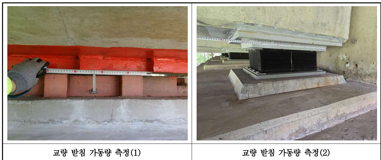
【사진 46.3.20】교량받침 이동량 측정
