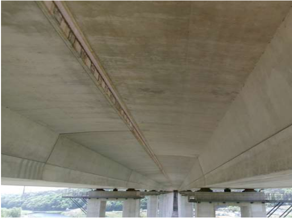
바닥판 종조인트 상태양호
