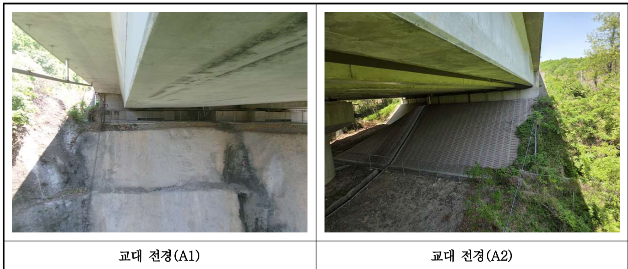
【사진 46.3.12】 교대 전경
