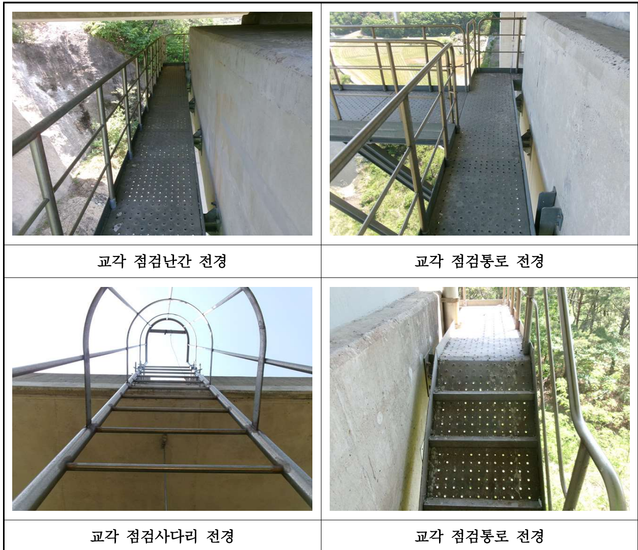
【사진 46.3.30】 교량 점검시설 전경
