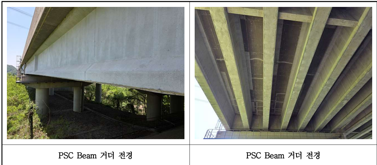
【사진 46.3.8】 PSC Beam 거더 전경
