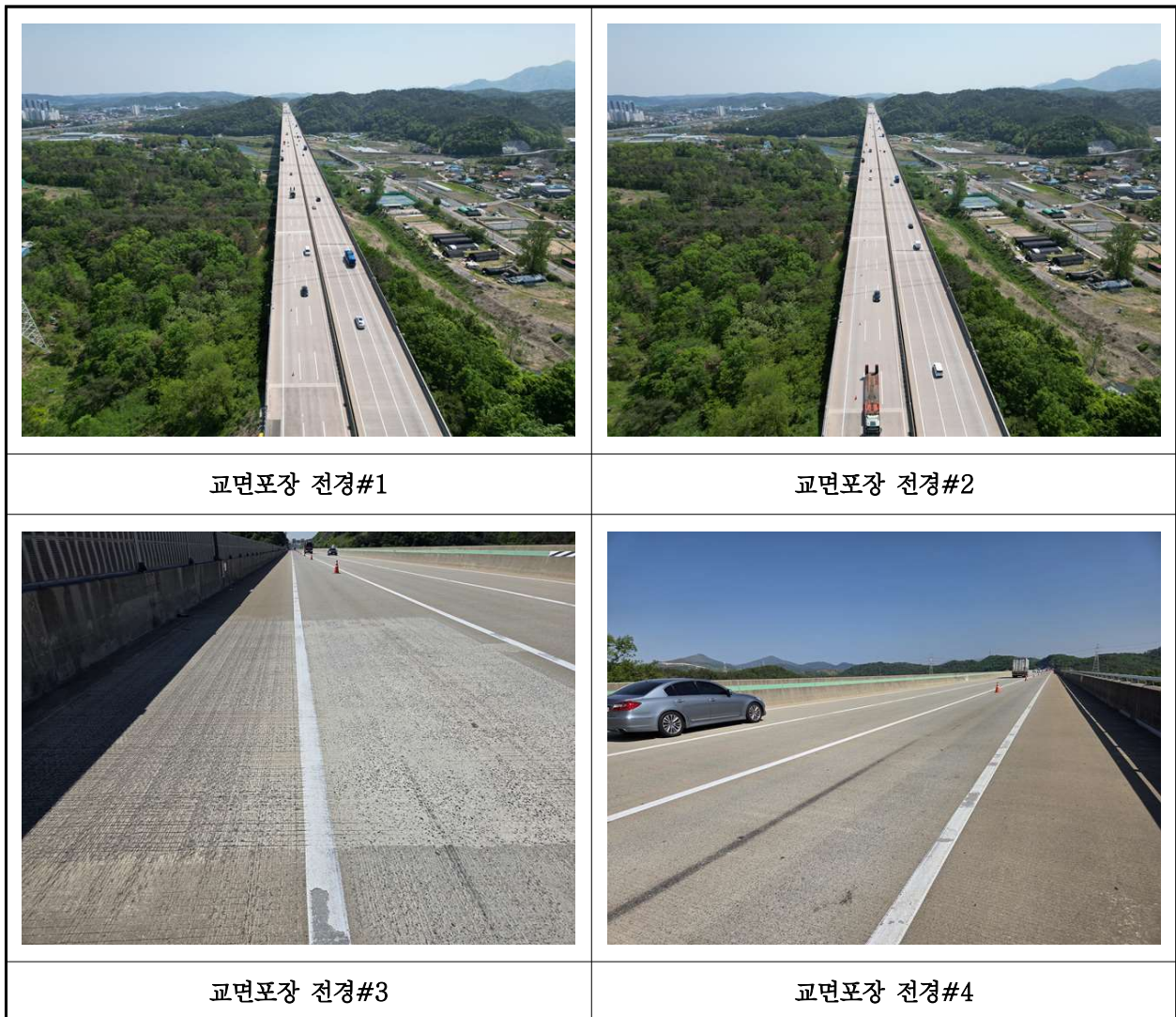
【사진 46.3.24】 교면포장 전경
