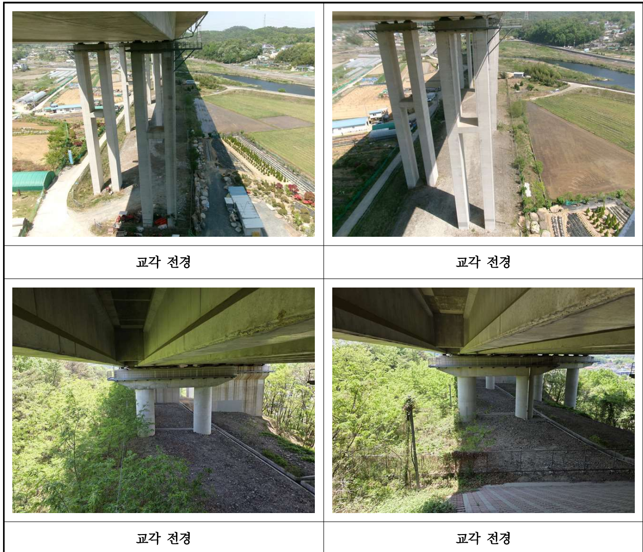
【사진 46.3.14】 교각 전경
