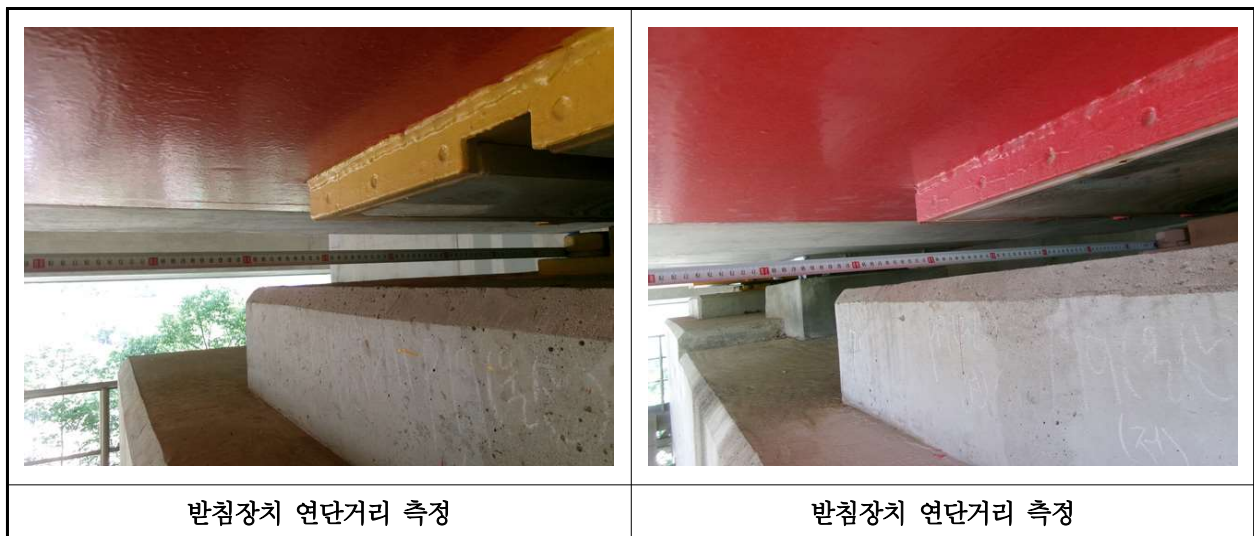
【사진 46.3.19】 교량받침장치 연단거리측정
