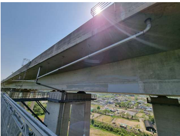
교량 배수관 상태양호
