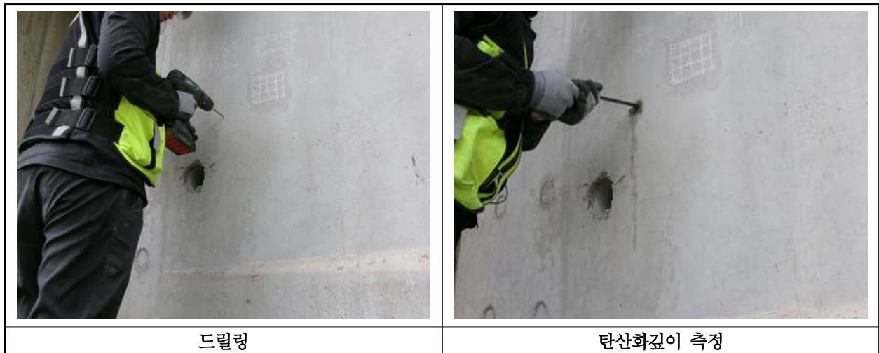
【사진 46.4.3】 탄산화 깊이 측정 현장사진
