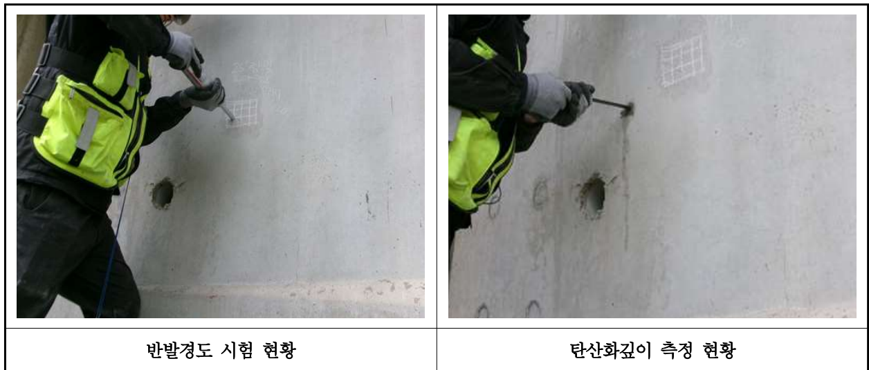
【사진 46.4.1】 콘크리트 내구성조사 현황
